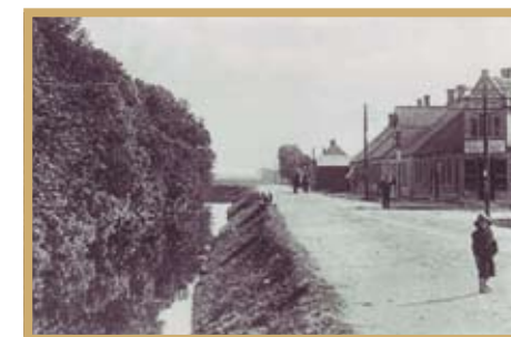
Aagade før kirken blev bygget.
